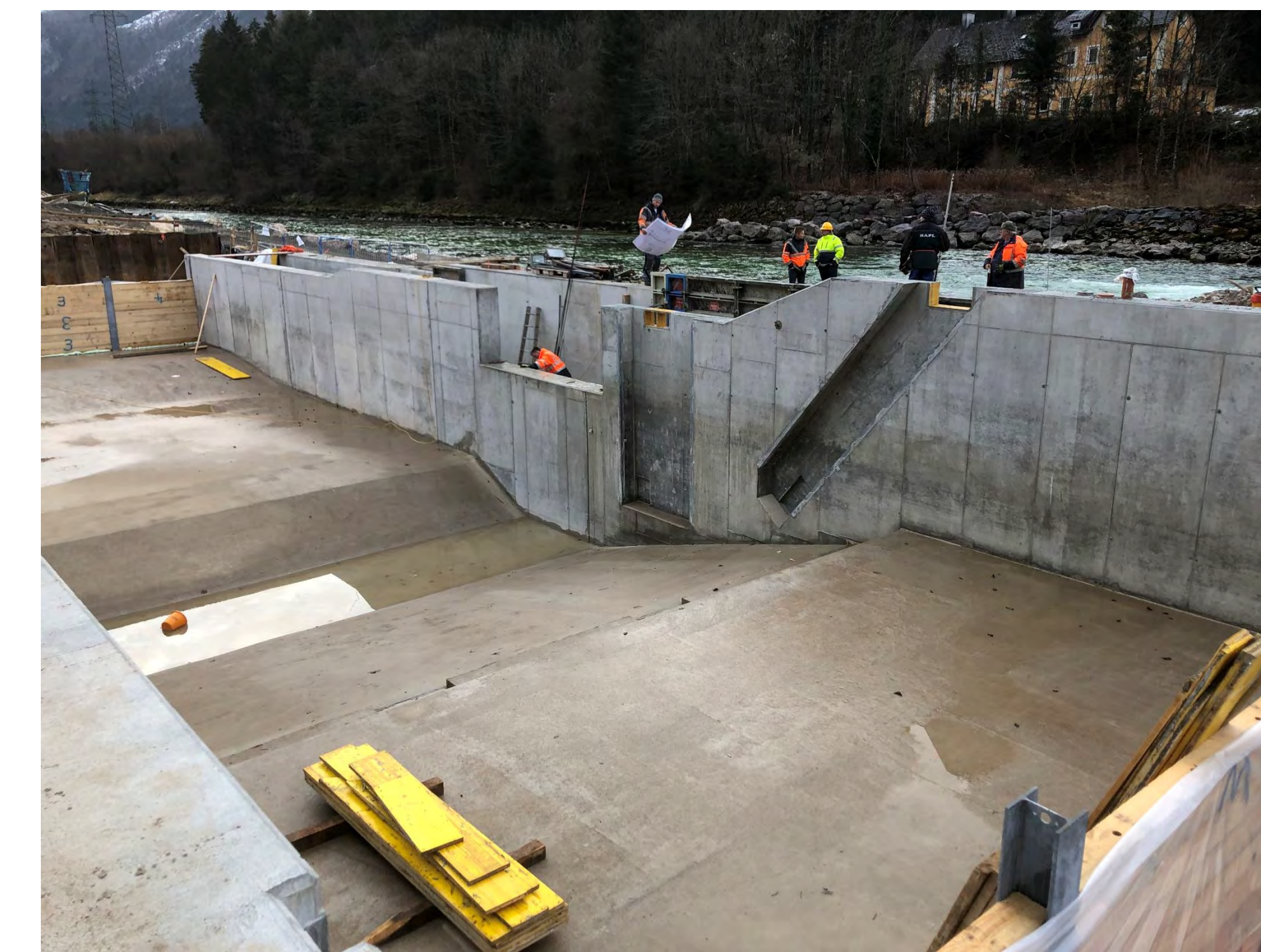
Kanalsohle und seitliche Aussparungen
