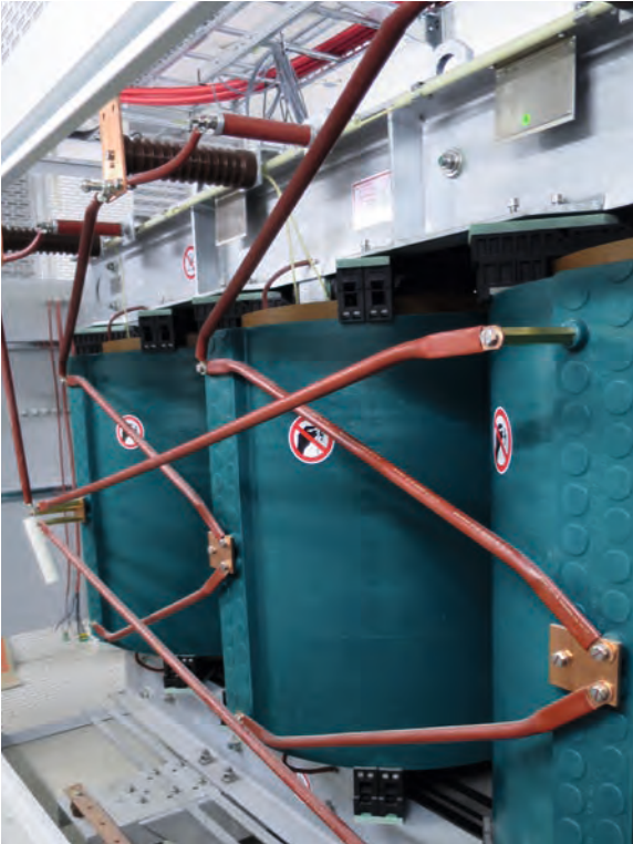
KAT – Garching, Notstromdiesel
