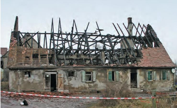
Massiver Brandschaden bei einem Wohnstallhaus. Das historische Dachwerk ist beinahe vollständig zerstört.
