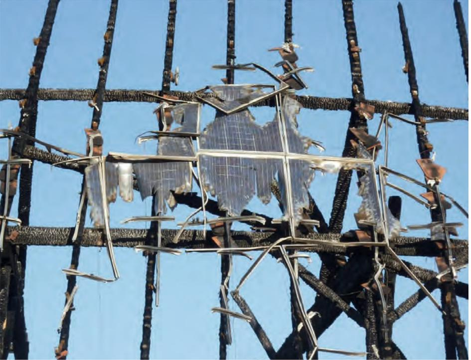
Reste einer Photovoltaik-Anlage nach einem Dachstuhlbrand.
