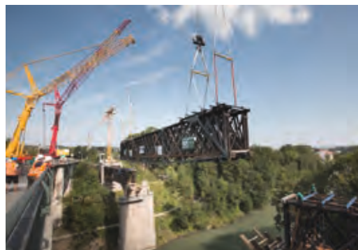
Sanierung der Historischen König-Ludwig-Brücke
