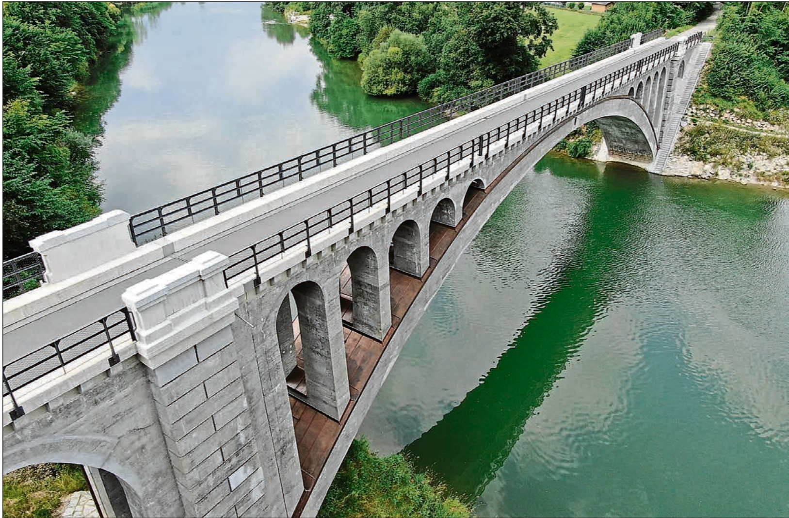
Die Illerbrücke Illerbeuren ist 90 Meter lang und hat eine Höhe von 13 Metern.
