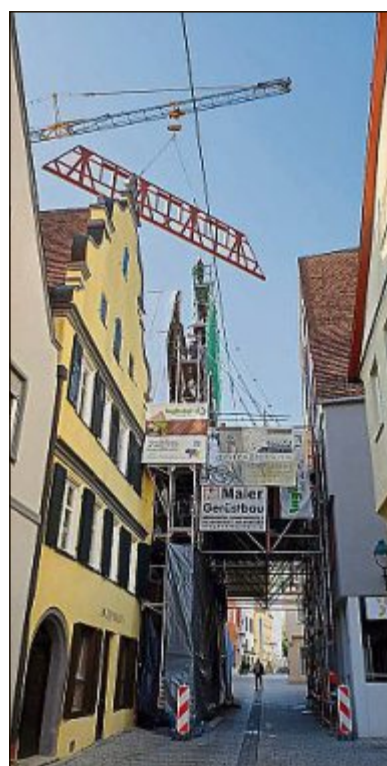
Die Giebelelemente mussten mit dem Kran auf die Gebäudevorderseite gehoben werden.
