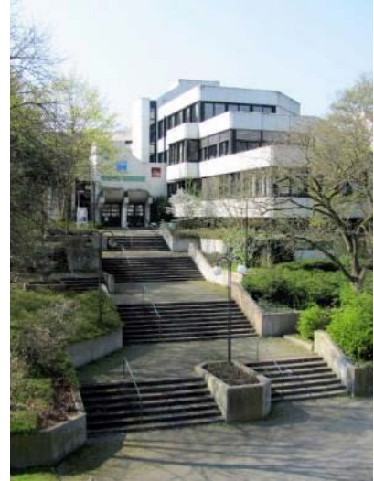
Foto vorher: Erich Bocklenberg
